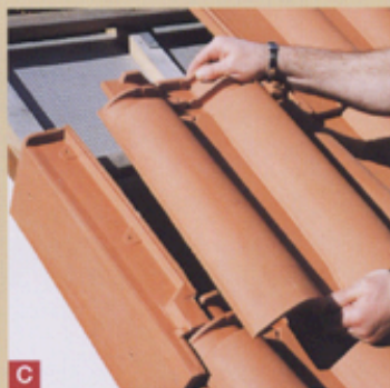
C Pose et fixation de la tuile double bourrelet et rive individuelle gauche
