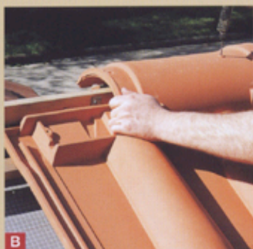
B Faîtière avec tuile de sous-faîtage
