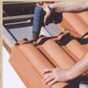
C Pose et fixation de la tuile double bourrelet et rive individuelle gauche
