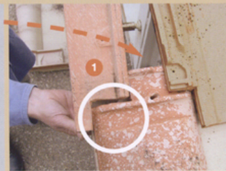
I Découpe de la demi-tuile du rang inférieur pour passage de rive et étanchéité (mastic-colle ou autre...)
