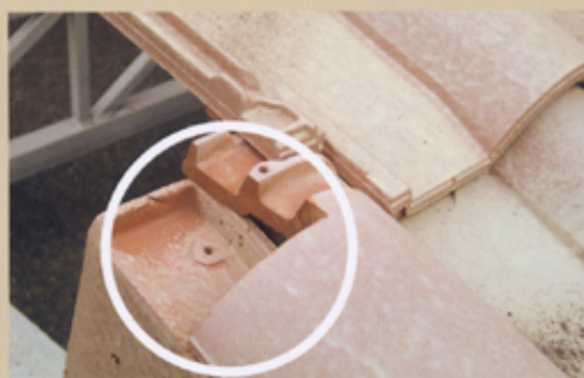
E Mettre en place une étanchéité à la mise en œuvre (mastic-colle ou autres...)
