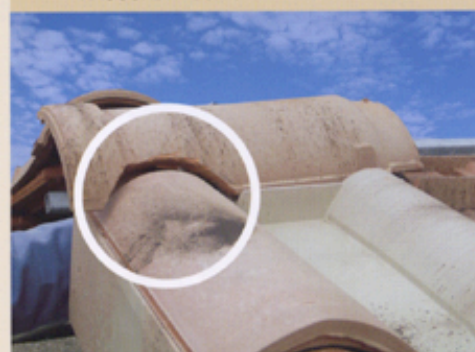
G Découpe et étanchéité avec faîtière (mastic-colle ou autres...)
